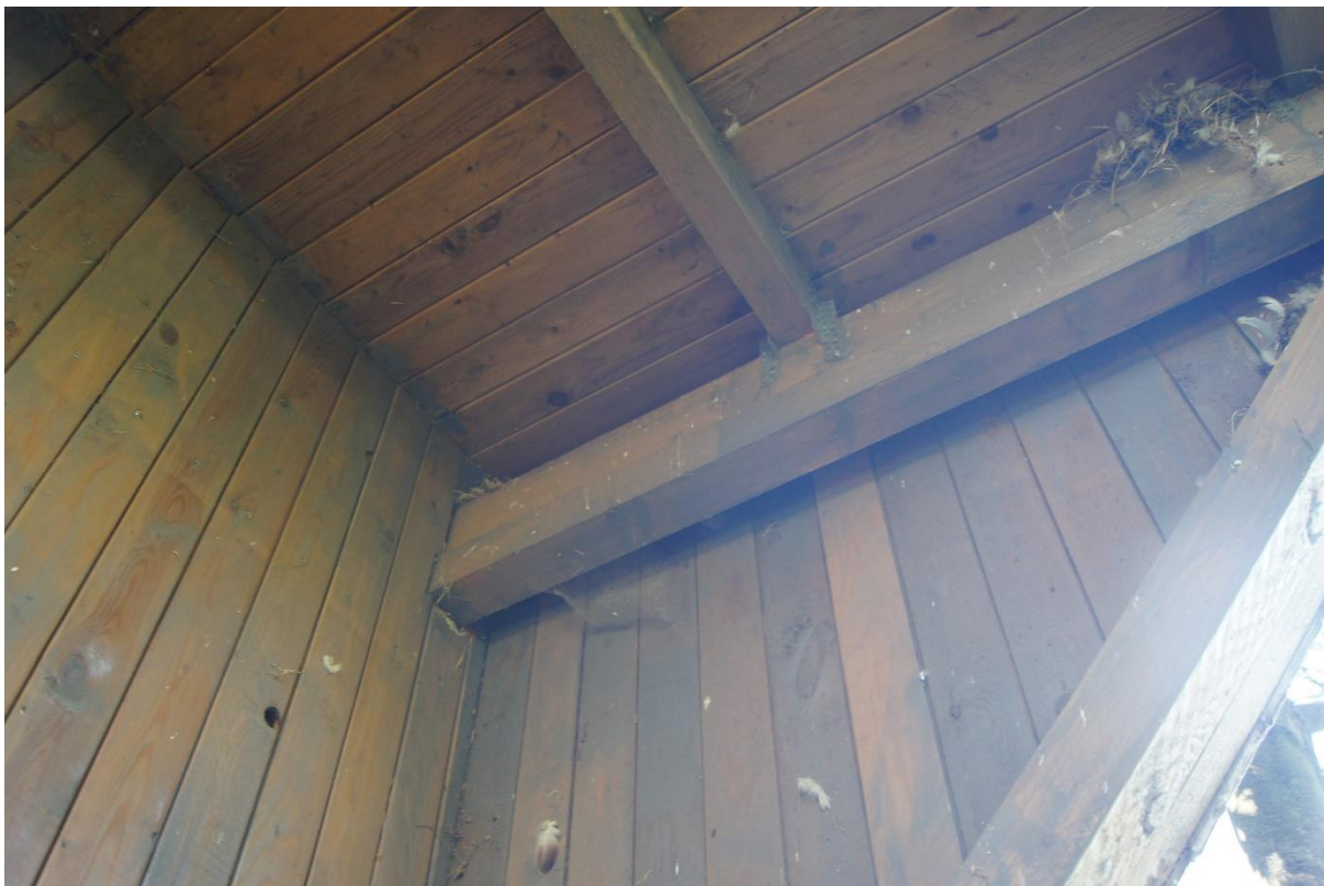
Bild 27 Gebäude 06 Schuppen Nordwestseite - Bachstelzennest
