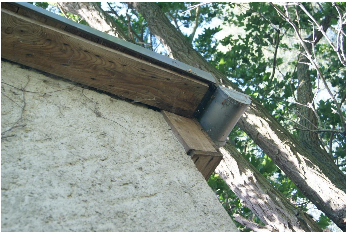
Bild 15 Gebäude Bild 02 Nordwestgiebel- Dachkasten und Dachauflage fest gefügt
