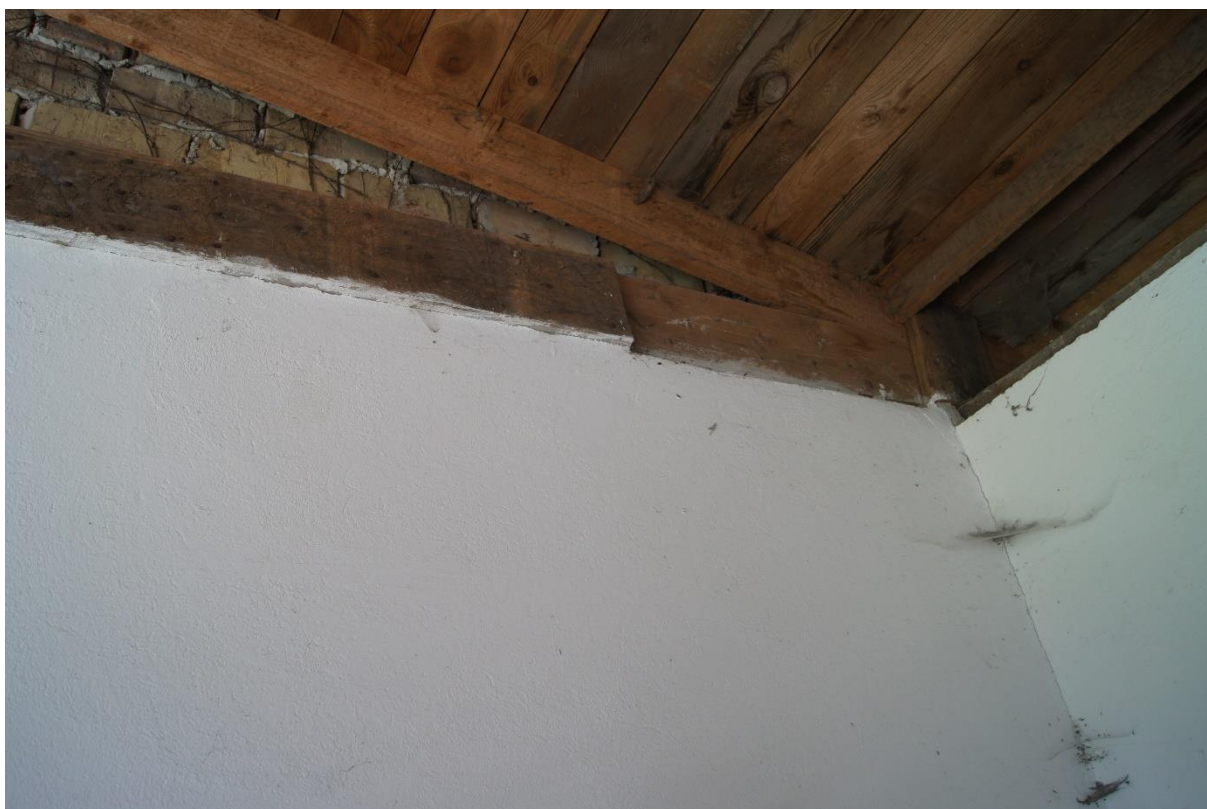
Bild 18 Gebäude Bild 02 Unterstand im Norden – potenzielle Spaltenquartiere
