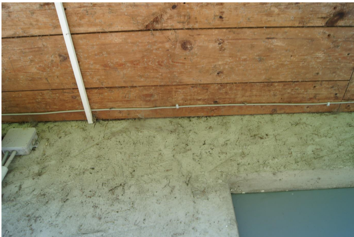
Bild 21 Gebäude Bild 02 Südgiebel fest gefügt
