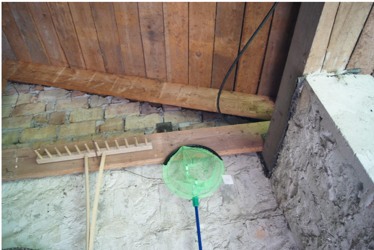
Bild 19 Gebäude Bild 02 Unterstand im Norden – potenzielle Spaltenquartiere
