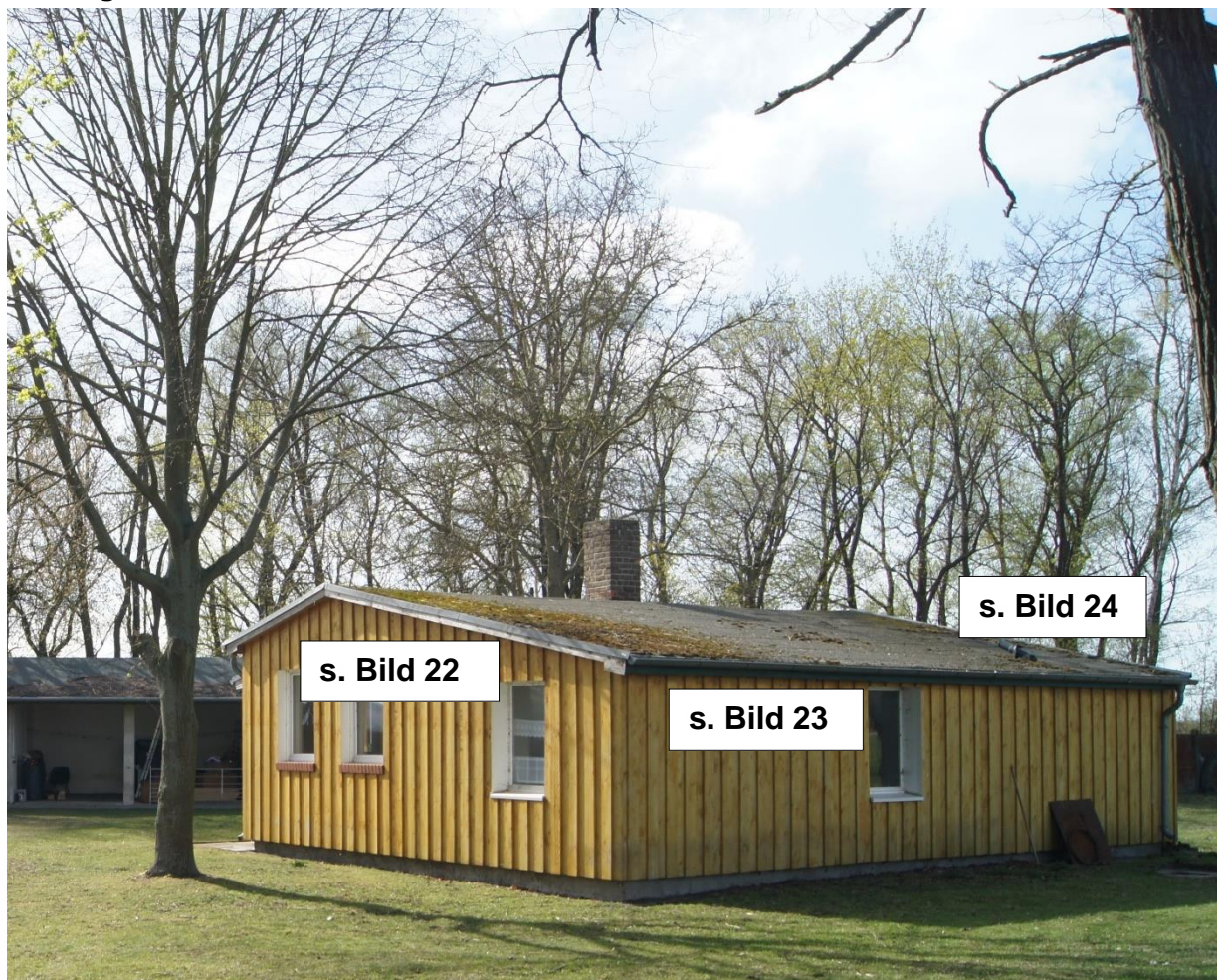
Bild 01 Aufenthaltsgebäude- im Hintergrund und Linde Gehölzerhaltung (nördliches Baufeld vom Süden)
