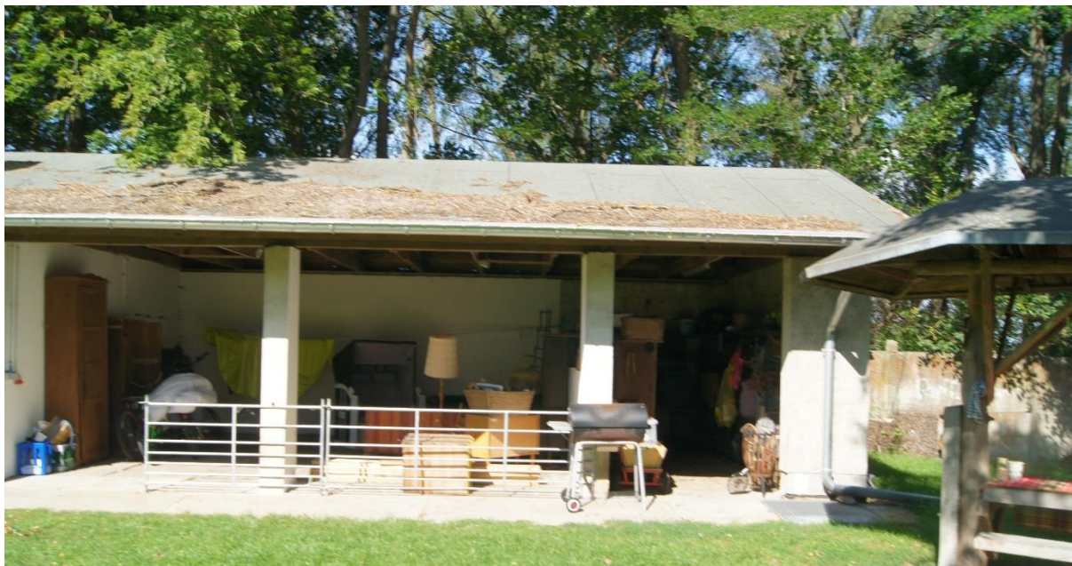
Bild 17 Gebäude Bild 02 Unterstand im Norden vom Osten
