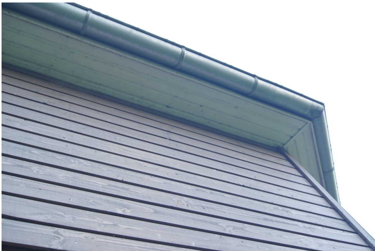
Bild 25 Gebäude 04 Laube (Pavillon) – Ostseite fest gefügte Bauteile
